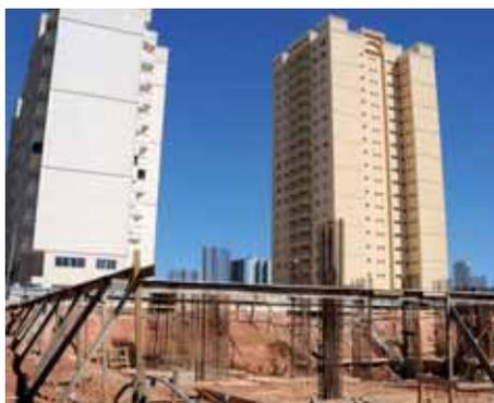
**BLOCO B** – Foram retomados os trabalhos dos blocos de fundações (subsolo). A seguir serão executadas as cortinas de concreto do subsolo e, depois, os blocos do térreo.
