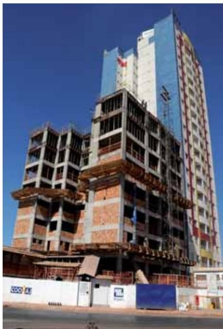
**BLOCO B** - No dia 21, foi concretada a oitava laje do pavimento-tipo, estando prevista a execução de outra para o dia 28, totalizando três lajes no mês. Para agosto estão previstas quatro lajes e para setembro mais cinco, atingindo o 18º pavimento-tipo. Paralelamente, estão sendo executadas as alvenarias dos apartamentos e iniciadas as tubulações elétricas.
